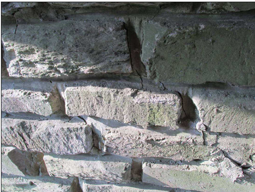
Obr. č. 8 – detail na lokálně porušené zdivo - opěra Troubelice, levá část
