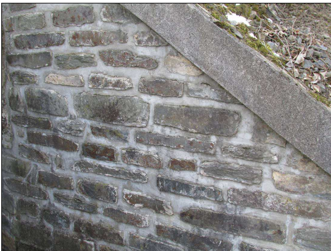
Obr. č. 9 – detail na zdivo křídla - opěra Troubelice, vpravo
